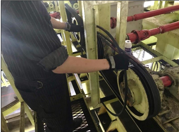
◇ゴンドラリフト場内整備
