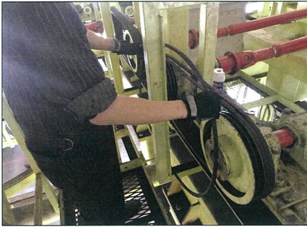
◇ゴンドラリフト場内整備
